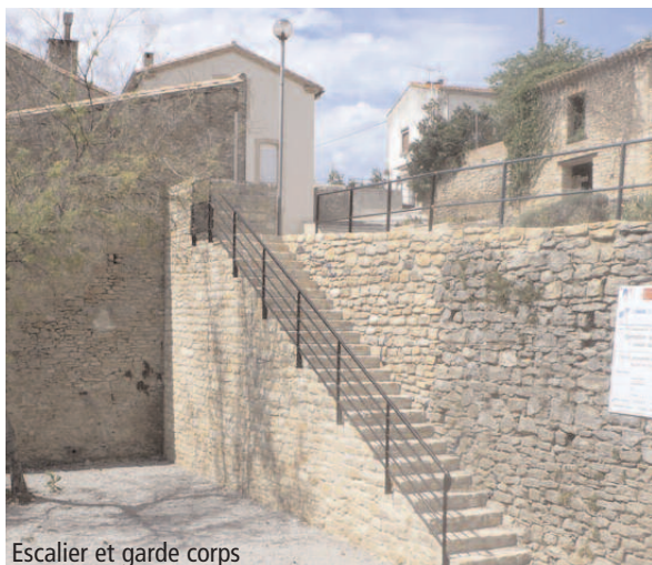
Escalier et garde corps
